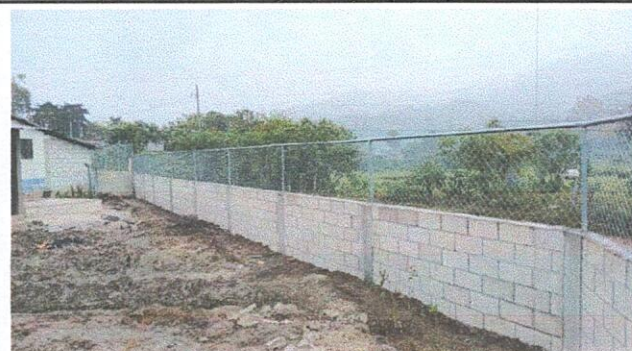
Foto 2: MEJORAMIENTO DE MURO PERIMETRAL
