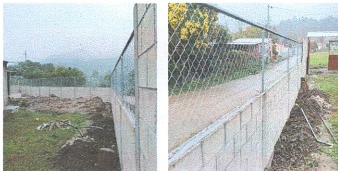
Foto1: MEJORAMIENTO DE MURO PERIMETRAL
