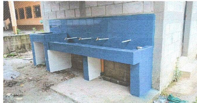
Foto 6: MEJORAMIENTO DE LAVAMANOS
