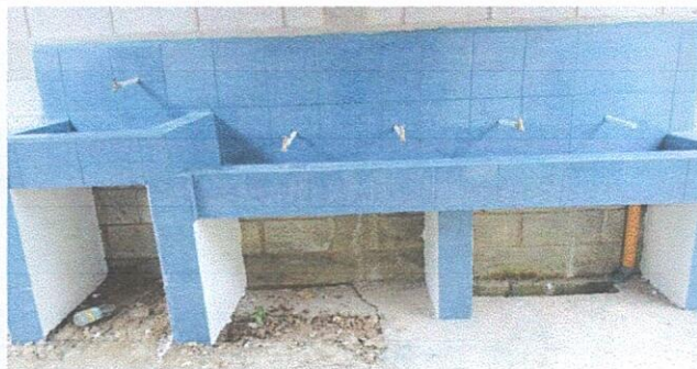
Foto 5: MEJORAMIENTO DE LAVAMANOS
